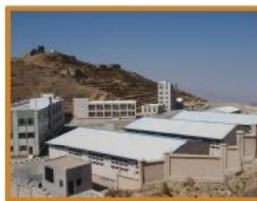
مشروع المعهد المهني - الجبين م/ريمة PROJECT INDUSTRIAL VOCATIONAL INSTITUTE, AL-JABEEN, RAYMAH
